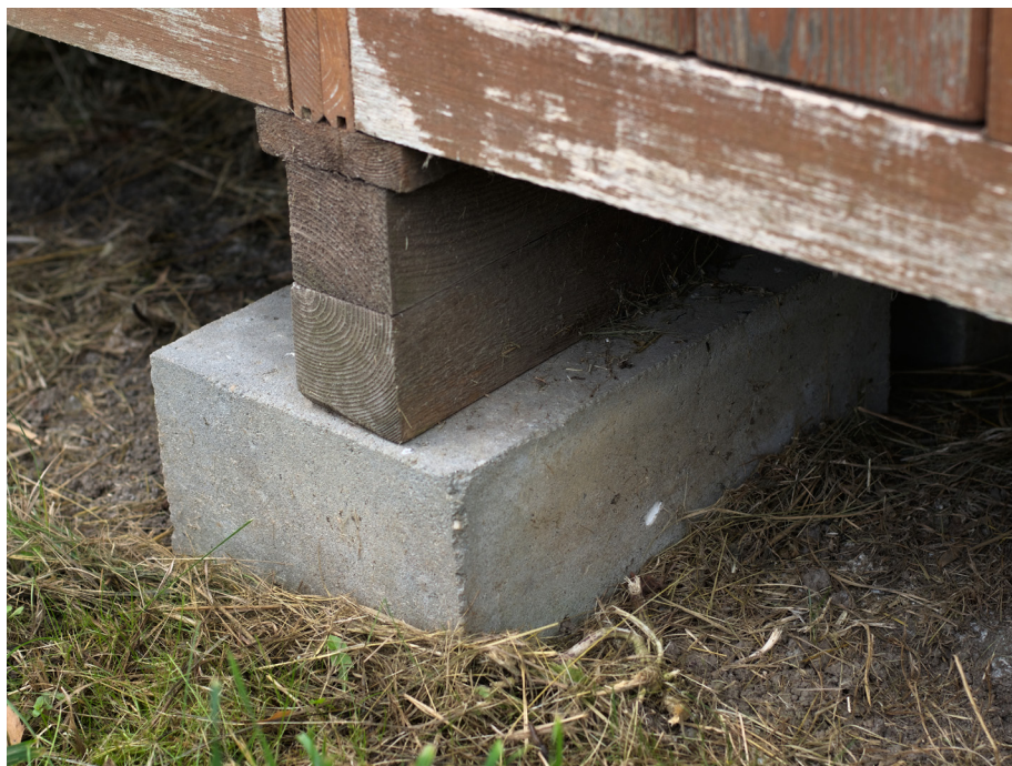
Fot.2. Drewniane nóżki klatki umieszczone na bloczkach betonowych
